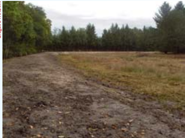
Étang mis en assec avec arrachage des saules en bordure et reprofilage de la digue.
