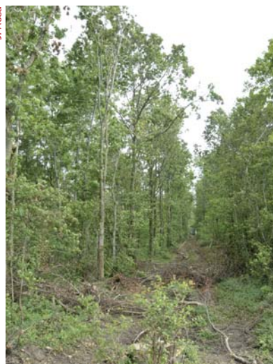
L'abatteuse circule sur le cloisonnement où elle a disposé les branches au sol pour limiter les dégâts de tassement.
