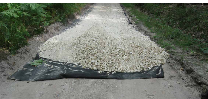
Le géotextile, très utile dans les zones mouilleuses, Pierre-Edmond Lelievre © CNPF
