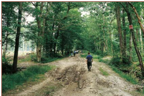
Voirie forestière dégradée
