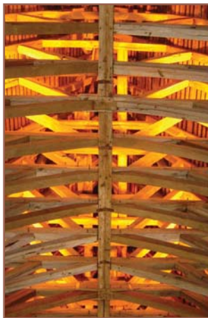
Charpente en chêne au Château de Sully-sur-Loire
