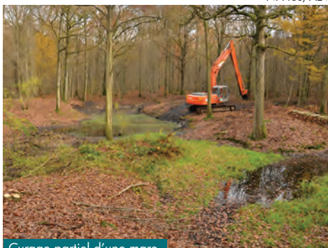
Curage partiel d'une mare
