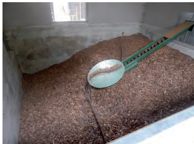
Silo de 30 m 3 avec extracteur rotatif, Milly-la-Forêt
