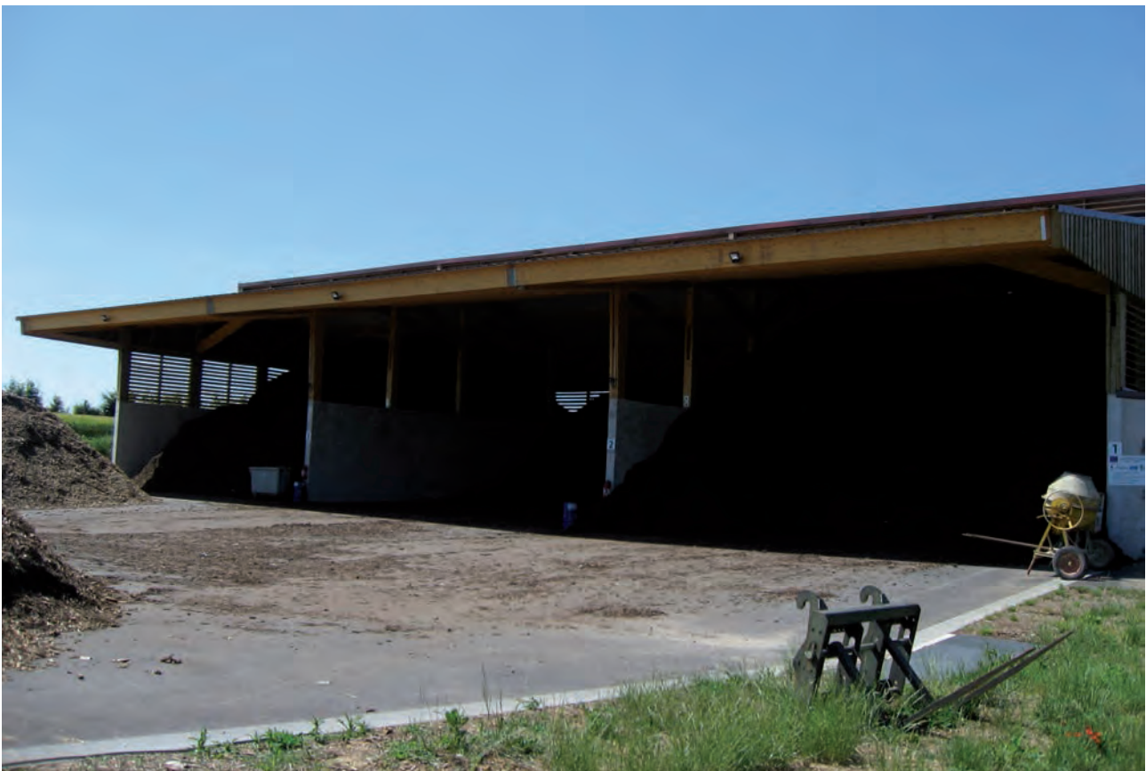
Hangar de stockage/séchage de plaquettes, Moigny-sur-École
