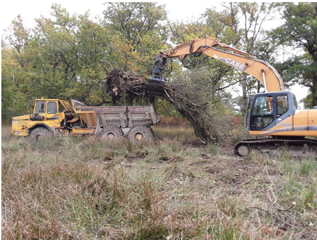
Travaux de réhabilitation d'étangs d'intérêt Natura 2000 en Sologne, arrachage de saules
